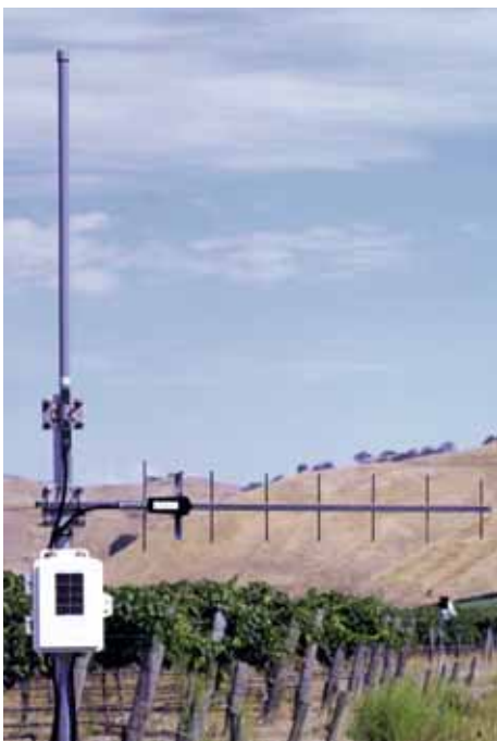
Lang-distance repeater med 1 Yagi og 1 Omni antenne
